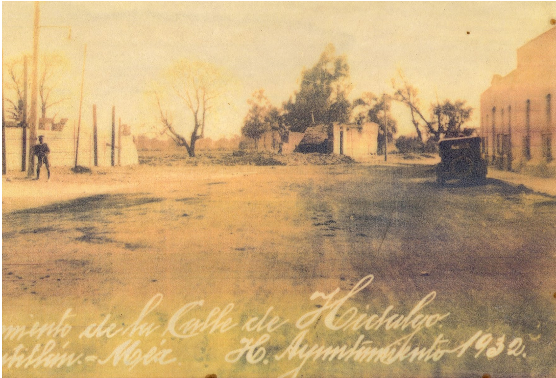
Imagen 98. Calle Hidalgo (arriba) y Calle Bolívar Sur (abajo, vista de sur a norte)
